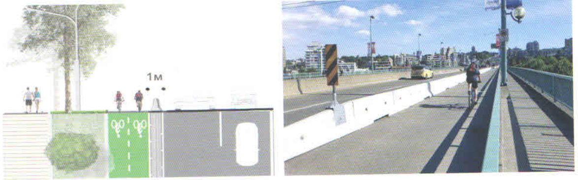
Зураг 15.3 Бетон хашлага бүхий замын тусгаарлалт
